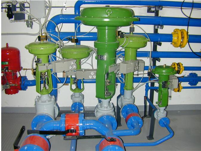
Fig. 1 :Valvole di regolazione e diaframmi di misura della portata
